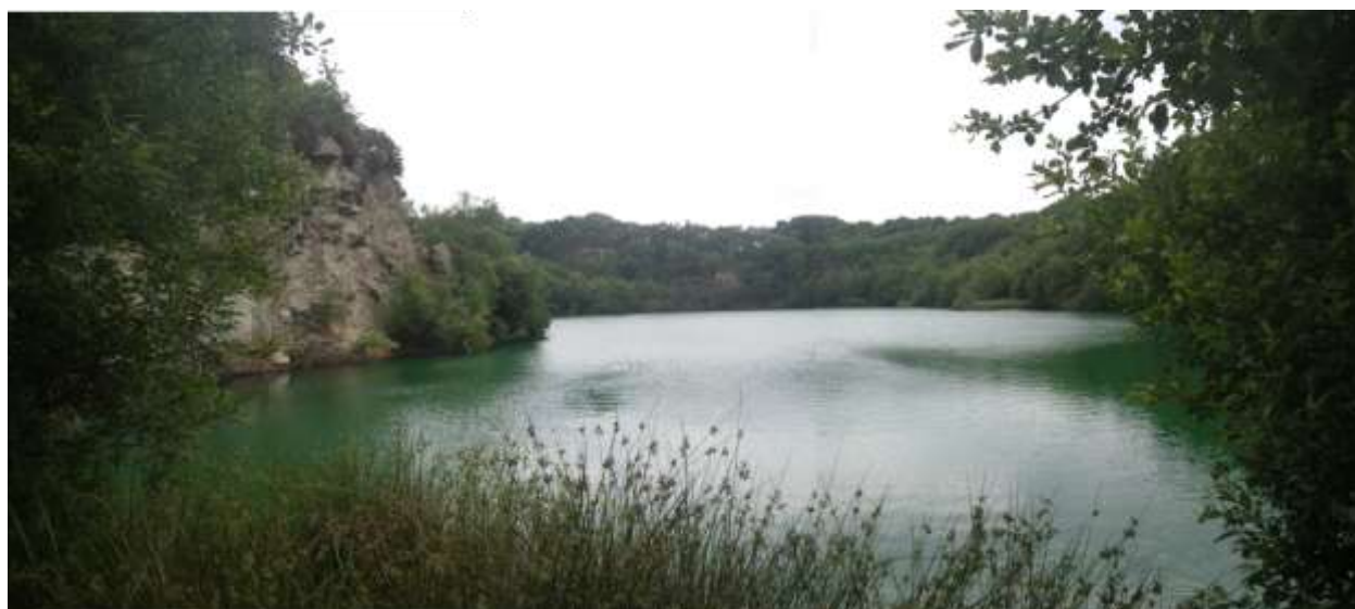
Illustration 95 : Vue vers le sud de la fosse de la carrière de Saint-Martin-des-Champs (BRGM, 2022)
