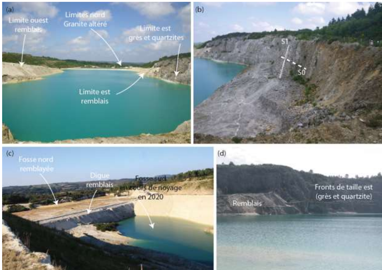
Illustration 34 : (a) Photographie vers le nord-ouest de l'ensemble de la carrière de Berrien. (b) Photographie des grès et quartzites présentant un débit en fonction de la stratification S0 et d'une schistosité de fracture S1. (c) Photographie 5 de la carrière en 2020 montrant la digue séparant les deux fosses. (d) Photographie d'une partie du front de taille est de la carrière montrant des remblais au nord et les grès et quartzites au sud-est (BRGM, 2022)
