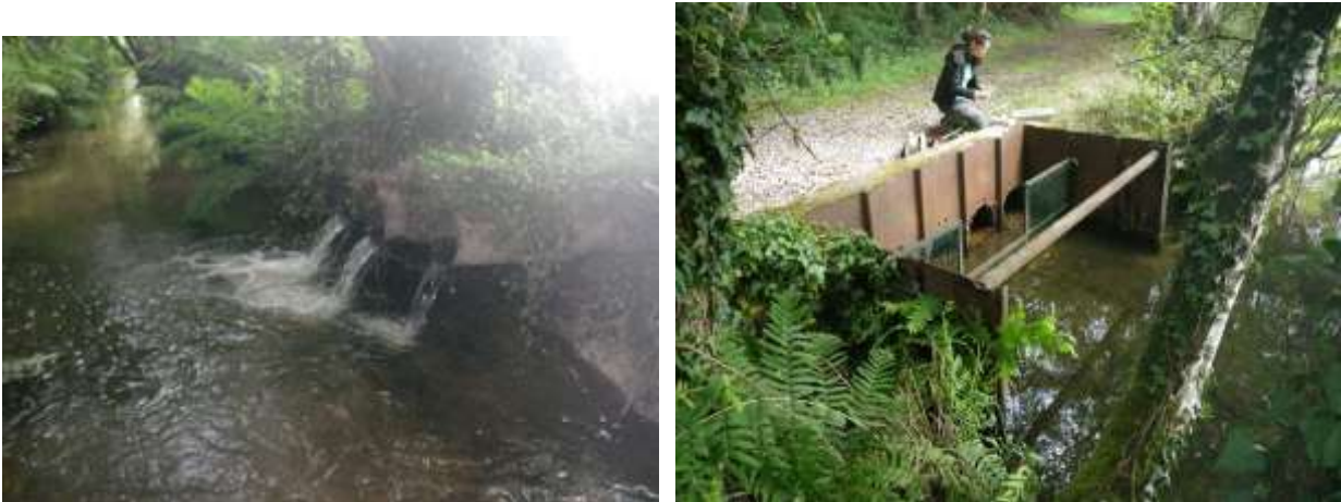
Illustration 82 : Surverse de l'étang (à droite) vers l'Aber Ildut (à gauche –BRGM, juin 2022)
