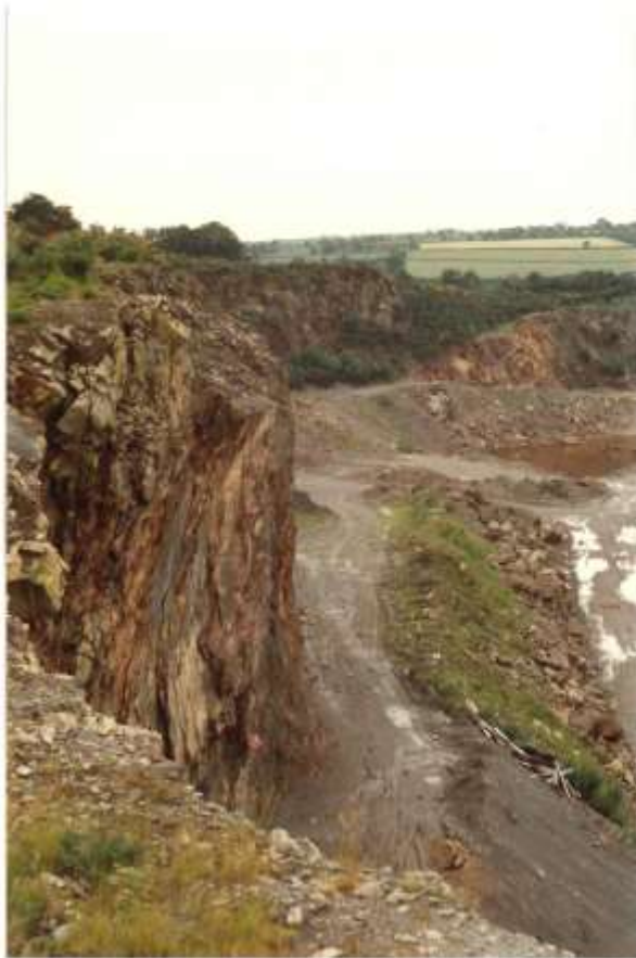
1-POINTE SUD-EST : RISQUE D'ECROULEMENT DE MASSES ROCHEUSES
