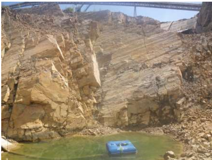
Illustration 122 : Pompe d'exhaure dans la fosse est et suintements le long de la paroi (photographie BRGM)
