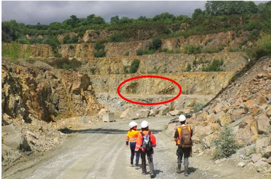
Illustration 121 : Suintements observés au niveau du 4 ème palier dans la fosse est (photographie BRGM)
