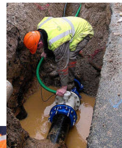
Crozon, pose d'un compteur de sectorisation (source : Télégramme)
